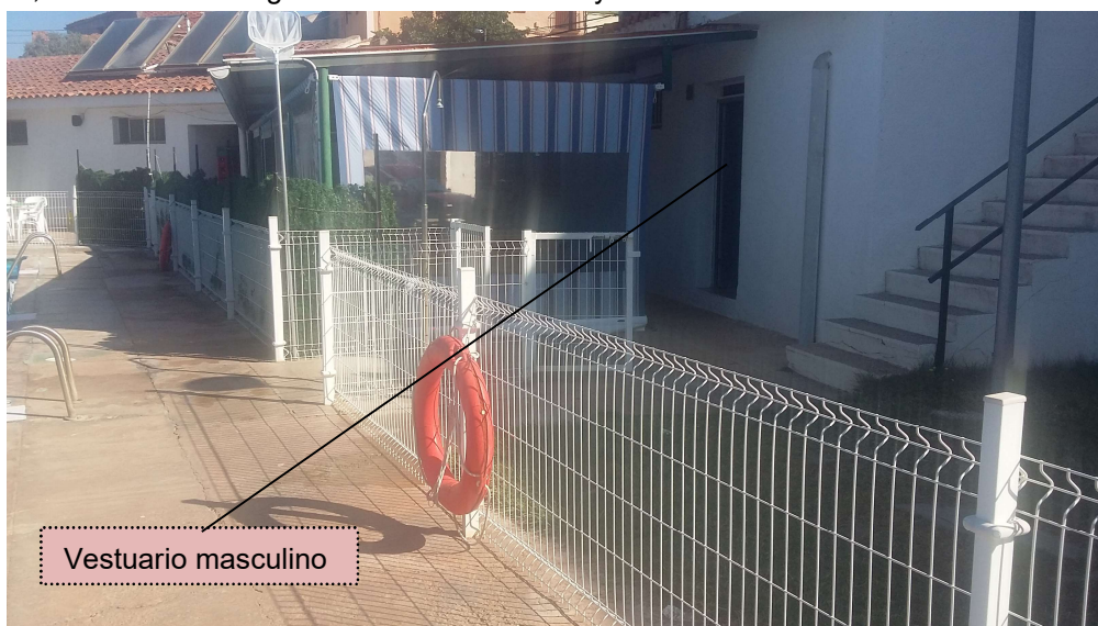
Foto 1. Estado actual de vestuario masculino y vallado.
